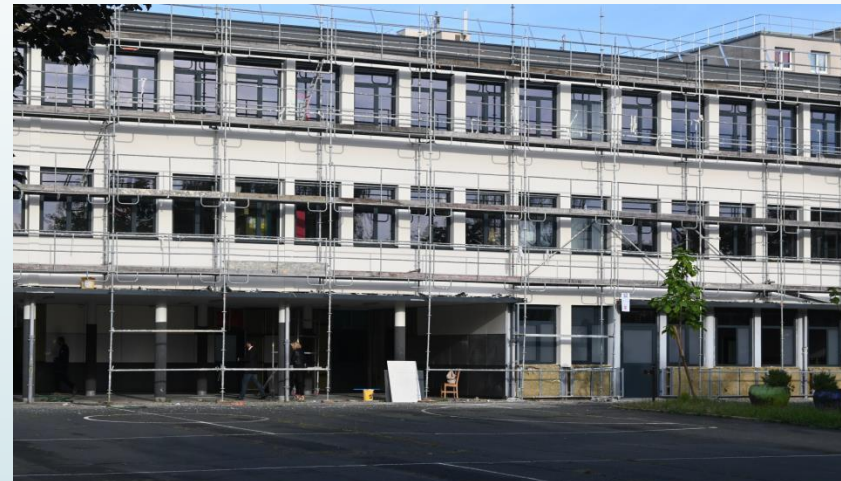
Travaux de rénovation thermique de l'école élémentaire l'Érable, durant l'été 2024.
